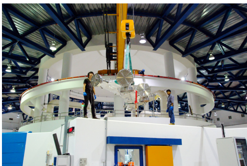
การติดตั้งชุดท่อสุญญากาศใหม่ในวงกักเก็บอิเล็กตรอน
